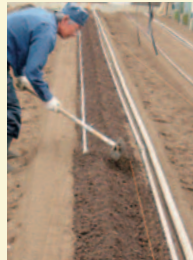
↑地中冷暖房用管を植床へ埋設する。
