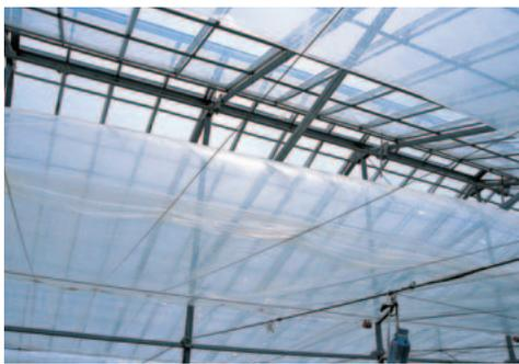
↑「ベストカーテン」は既設のカーテン上に強度のあるPOフィルムをのせて、ブロワーを取り付けるだけ。
