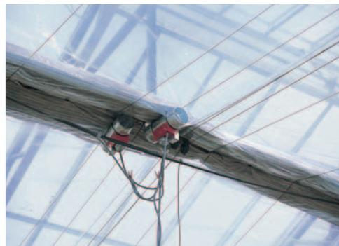
↑空気を制御するダンパーを使用し、タイマーで空気を抜く。
