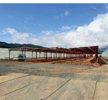
↑工事中の津谷川湾岸護岸工事とハウスの間には太陽光パネル施設の建設が進む。
