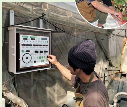
↑操作盤を見れば現在の設定や履歴がひと目で分かり、設定変更などの操作もタッチキーとツマミで簡単に行える。
