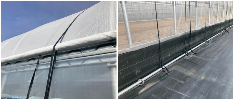
↑「涼感ホワイト」を下側のバンドでハウスに固定、上側のバンドでバタつきを抑える。
