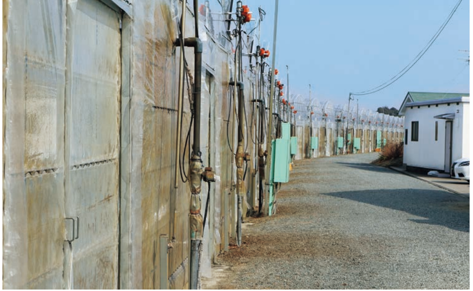
↑堺市南区の長峰地区にある連棟ハウス。太めのパイプが使用され、2018年の台風21号襲来時でも骨組みへの被害はなかった。
