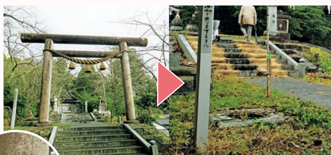
↑全国で唯一、田畑を守る「かかし」を主祭神とする久氏比古神社の鳥居。地震で根元に大きなヒビが入り、倒壊による二次被害を防ぐために撤去された。
